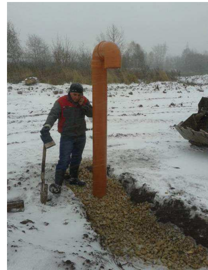
Рис. 2.14 — Газовыпуск при устройстве траншейной системы сбора биогаза (Пермский край) ([46])
