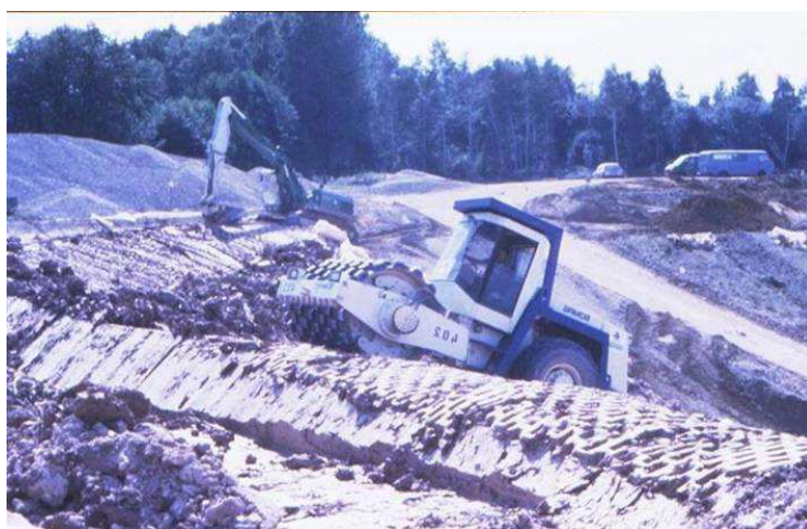
Рисунок 2.2 — Уплотнение глиняного экрана ([26])
